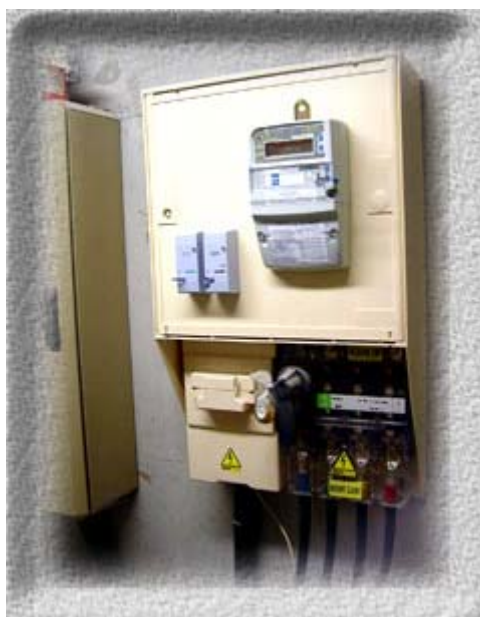
Exemple d'une armoire tarif jaune avec compteur EDF tri, téléreport et sectionneur
